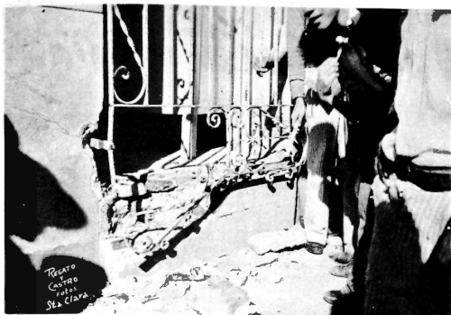
UNA BOMBA EN SANTA CLARA. —Efectos causados por la explosión de una bomba colocada por manos desconocidas en la residencia del señor Arturo Alemán, de Santa Clara, ex abogado consultor del gobernador Vázquez Bello. (Foto Regato y Castro).
